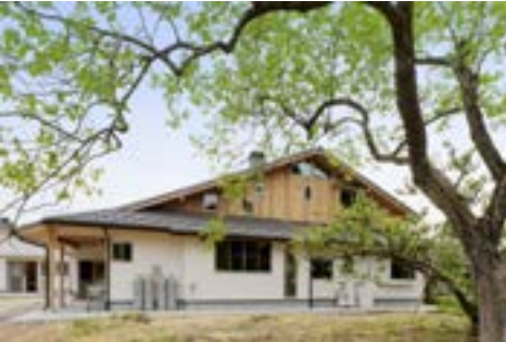
北側外観。外壁は2階をベイスギ張り、1階をそとん壁で仕上げている。
